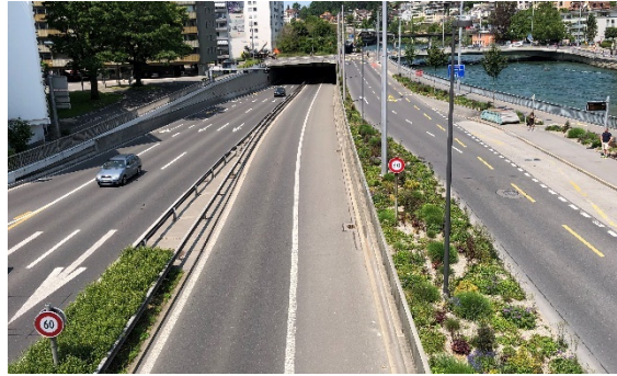
Abb. 27: Einfahrtsrampe Stadtautobahn (Blickrichtung Autobahn)
